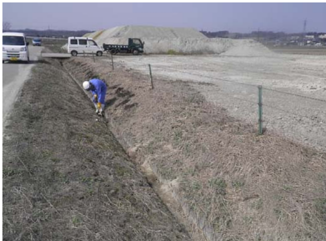
平成29年4月4日 当社越路事業所西津ストック場隣接地 排水路清掃状況
